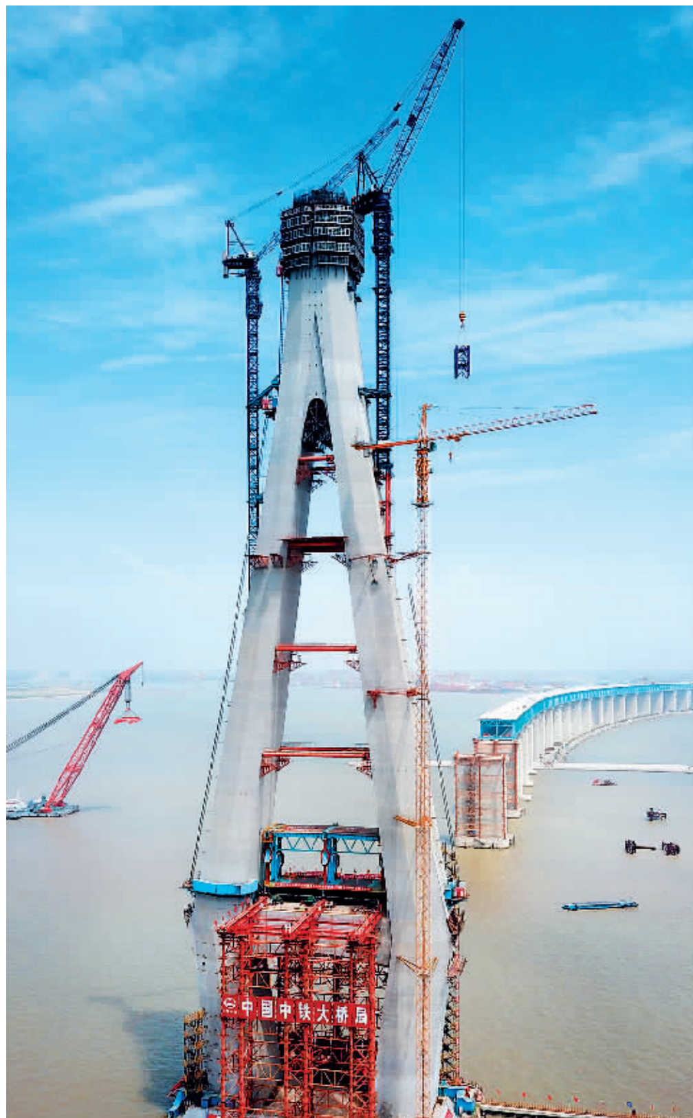
▲大桥主跨首节段钢梁架完成,标志着世界首次大节段钢桁梁吊装取得了成功。
