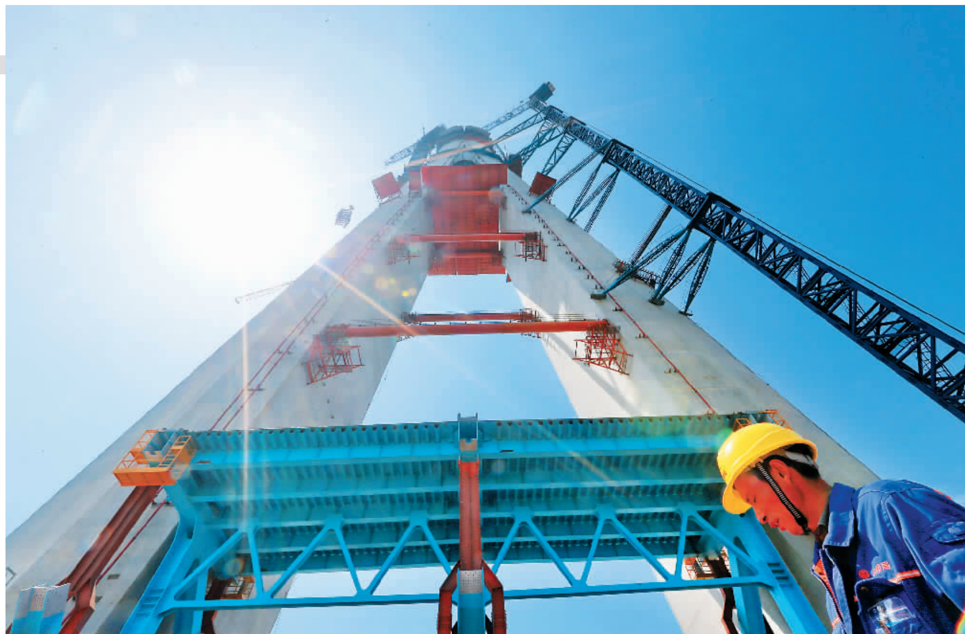
◀大桥主塔高325米,是世界上最高的公铁两用斜拉桥主塔;主跨1092米,是世界跨度最大的公铁两用斜拉桥。
