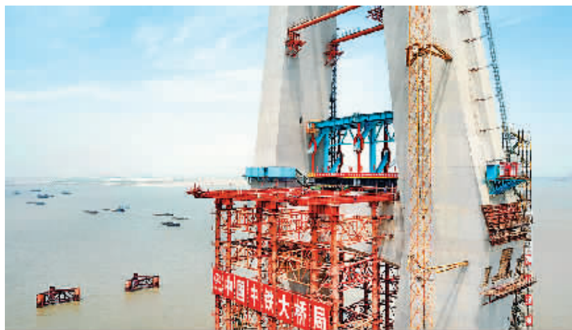
◀大桥主桥钢梁共164个节段,预计2019年10月完工。
