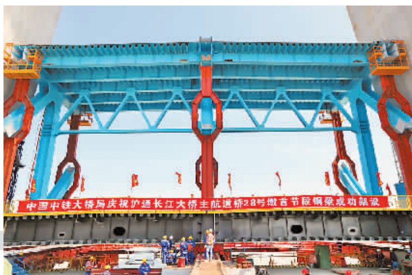
◀大桥建成后,将成为沿海重要的铁路、公路过江通道。
